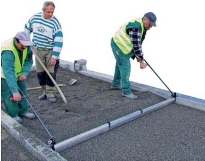
**Handgriffe HG-TP :** Satz bestehend aus 2 Stück, ermöglichen ermüdungsfreies Arbeiten in ergonomisch korrekter, stehender Körperposition
