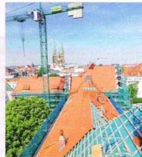
▲ Enorm wichtig: Der Baukran
